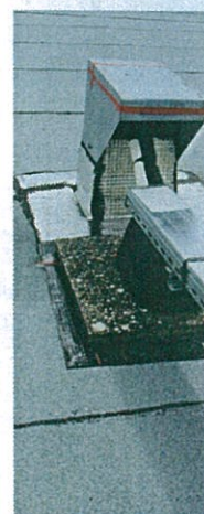
2. Un soin particulier a été apporté au passage des canalisations frigorifiques en toiture-terrasse. Des chemins de câbles ont été reconstitués sur des supports antivibratiles Big Foot avec une qualité qui devrait durer dans le temps.
